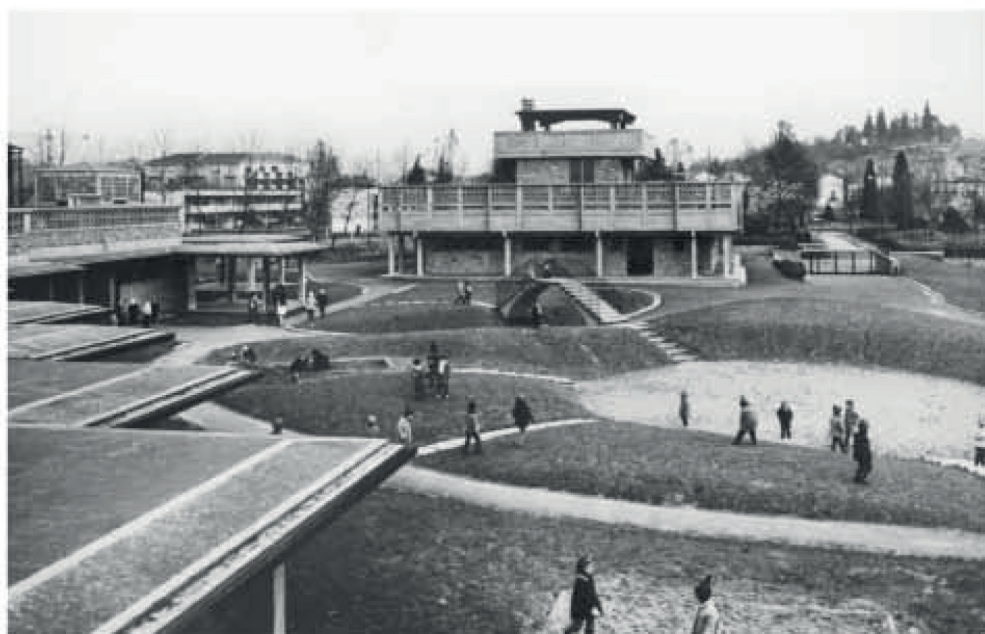
Vista d'insieme dell'Asilo d'infanzia Olivetti a Canton Vesco, Ivrea, architetti Mario Ridolfi e Volfrango Frankl. 1954-1964. Roma, Accademia Nazionale di San Luca, Archivio del Contemporaneo, Fondo Ridolfi-Frankl-Malagracci.
